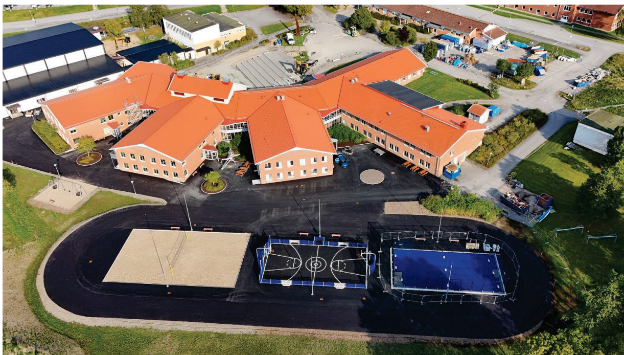
Renovering av Kungsmarksskolan i Munkedal – sep 2025. Foto: Erland Pålsson.
