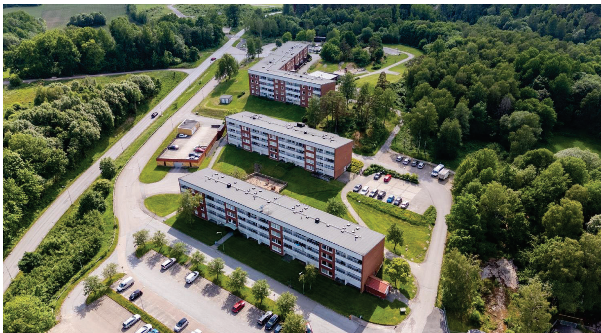
ROT-renovering har under året inletts på Brudås bostadsområde. Foto: Erland Pålsson.
